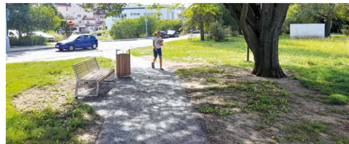
Vyšlapaná cestička u bývalého kina a zkratka mezi ulicemi 5. května a Šumavská dostaly mlatový povrch. Cesty byly navíc doplněny lavičkami a odpadkovými koši.
