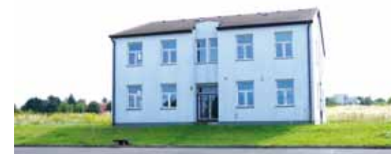
Nedostavěné budoucí sídlo KSÚS v ulici Kolovratská.
