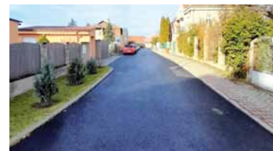
V rámci opravy v ulici Bezručova dostala nový asfalt i ulice Riegrova.
