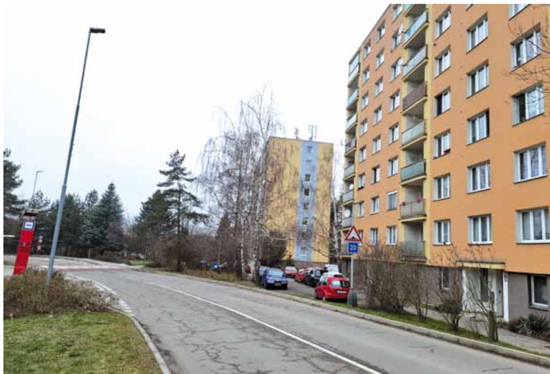
ŘSD vybuduje provizorní nájezd pro autobusy mezi ulicemi Olivova a U Vodojemu (před zvýšeným přechodem).
