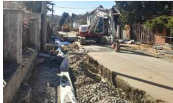
Kompletní rekonstrukce ulice Fibichova.
