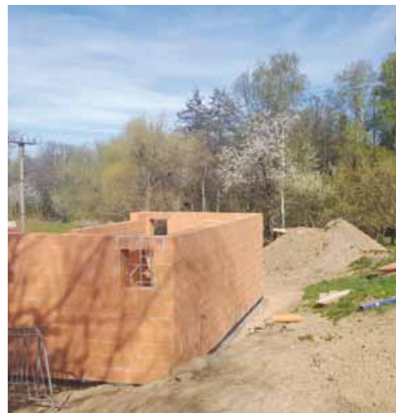
V ulici Na Kopešín vzniká nová automatická tlaková stanice.
